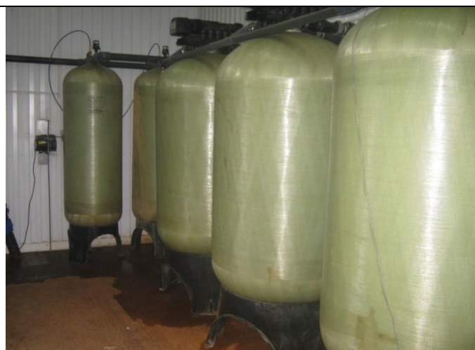
Рисунок 1.6 – Зал станции обезжелезивания центрального водозабора
