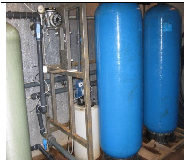
Рисунок 1.9 – Зал станции обезжелезивания водозабора по ул. О.Кошевого
